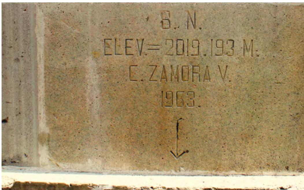
Registro de elevación sobre el nivel del mar inscrito en una losa de cantera puesta al pie de la escalinata en 1963 (OHD)
